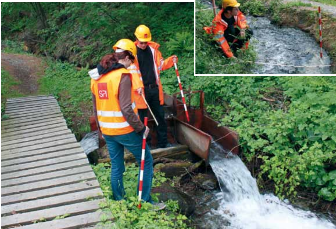
Der oberhalb des Dorfes durchführende Abschnitt verliert zu viel Sickerwasser.
