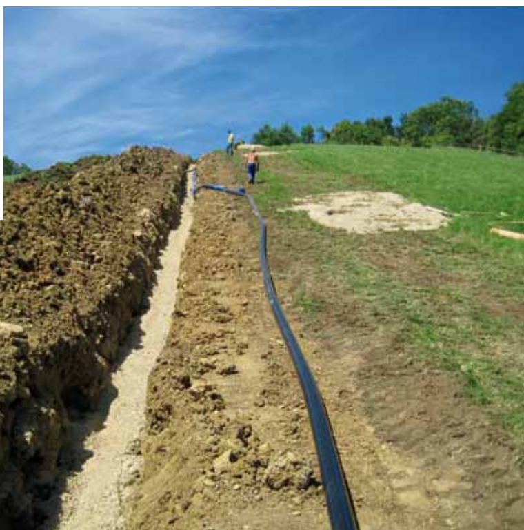
Die über 100-jährige Wasserversorgung von Roches ist erneuerungsbedürftig.
