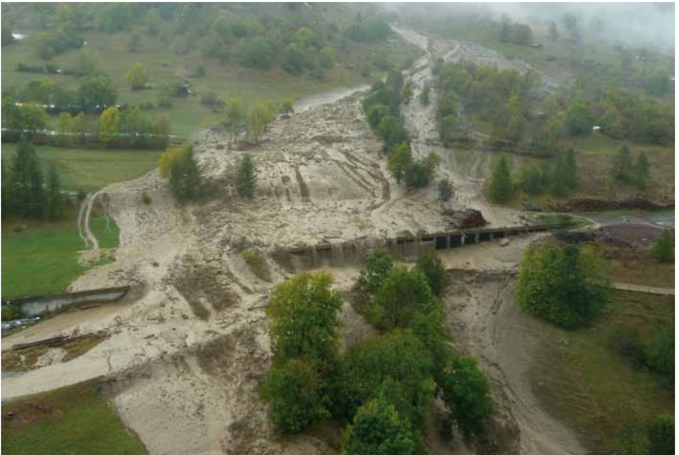
Auch im Lötschental verursachten die Unwetter Schäden von mehreren Millionen Franken.
