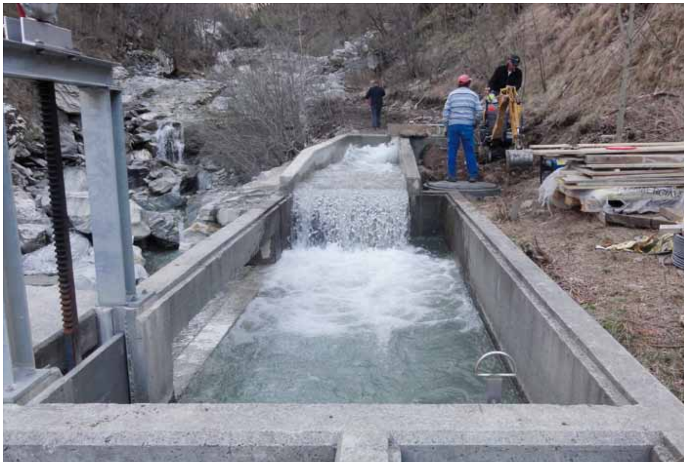
Wo es nötig ist, werden die Holzkännel durch moderne Wasserfassungen ergänzt.
